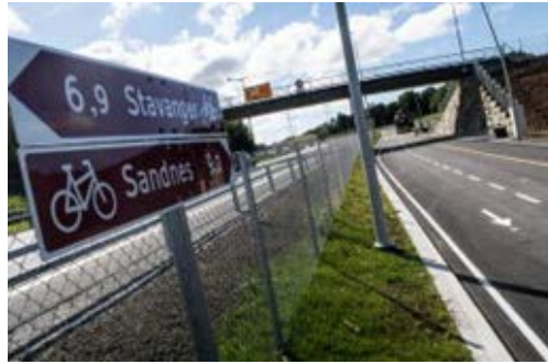
Figur 16. Kollektivutbygging og sykkelveger er to av dei viktigaste behovsområda for transportnett i byane. Høg statleg finansiering er nøkkelen for å kunne realisere nye, viktige infrastrukturtiltak.
